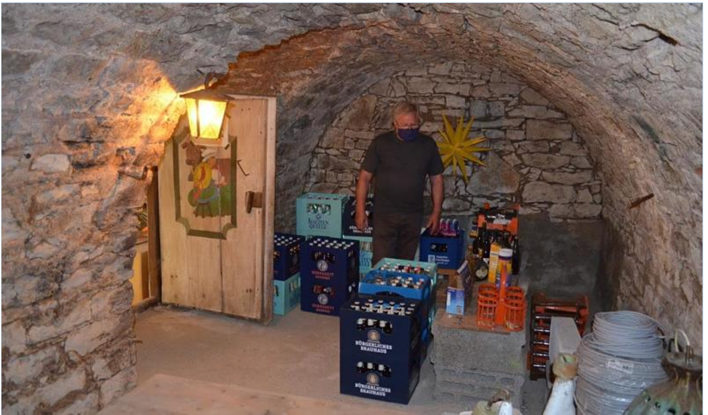
Auch nach der Sanierung soll das Haus seinen Charakter behalten. | Foto: Erl
